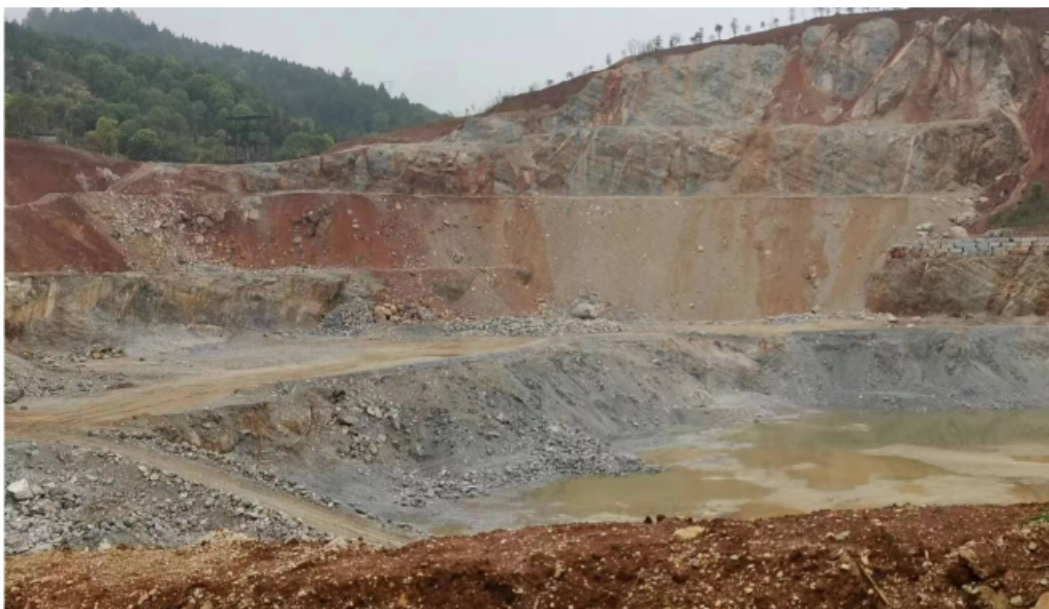
图 2-4 基建结束现场
